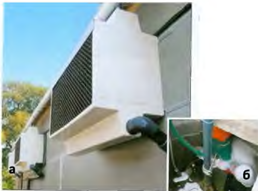
Рис. 6.15. Подача воды в систему Coolbox с помощью погружного насоса: а) кассета; б) подача воды
