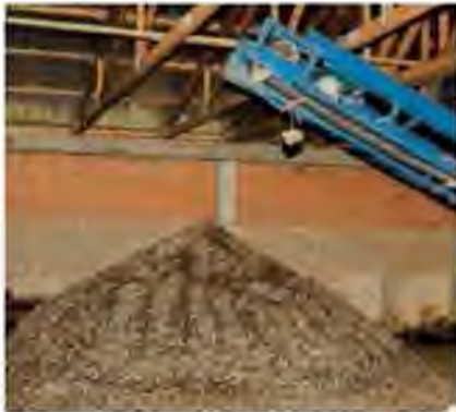
Рис. 7.10. Пометохранилище сухого помета
