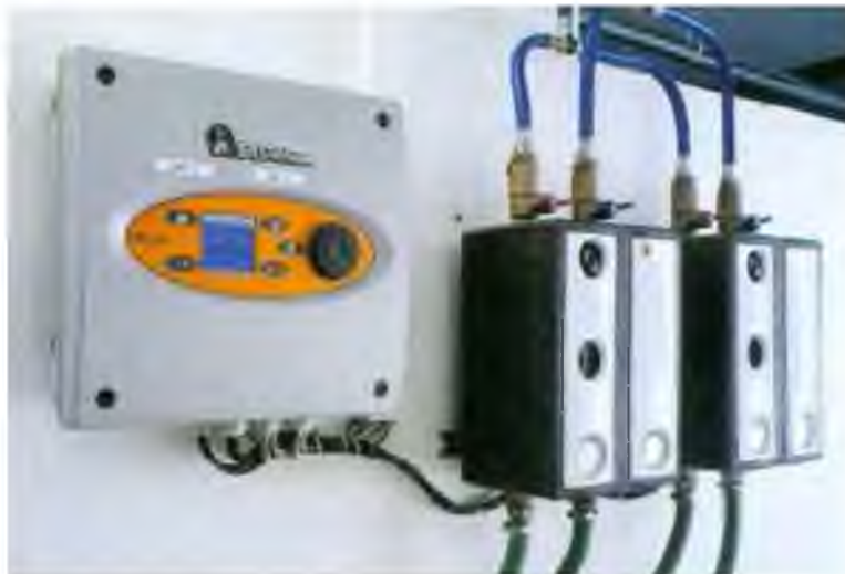
Рис. 6.25. Компьютер МС 235 для управления микроклиматом в помещении и трехходовым регулировочном краном для водяного отопления
