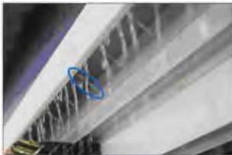
Рис. 11.29. Верхний профиль с перфорированной трубой и дефлектором
