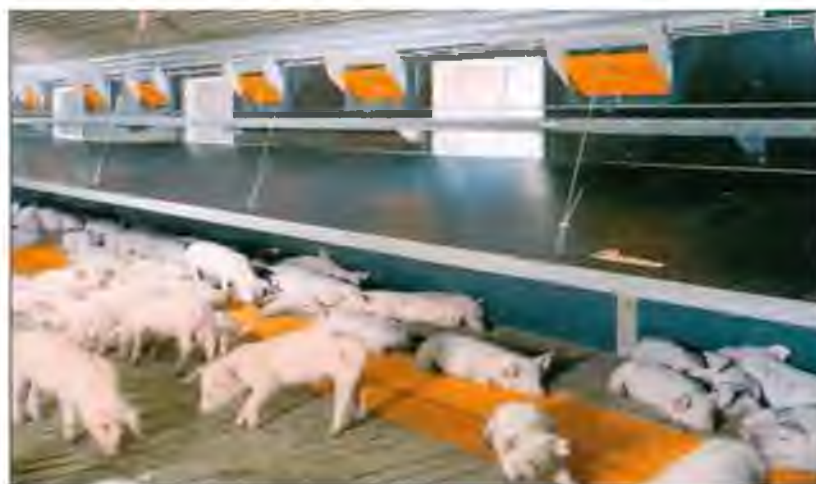
Рис. 6.21. Ребристые трубы, смонтированные для отопления участка доращивания
