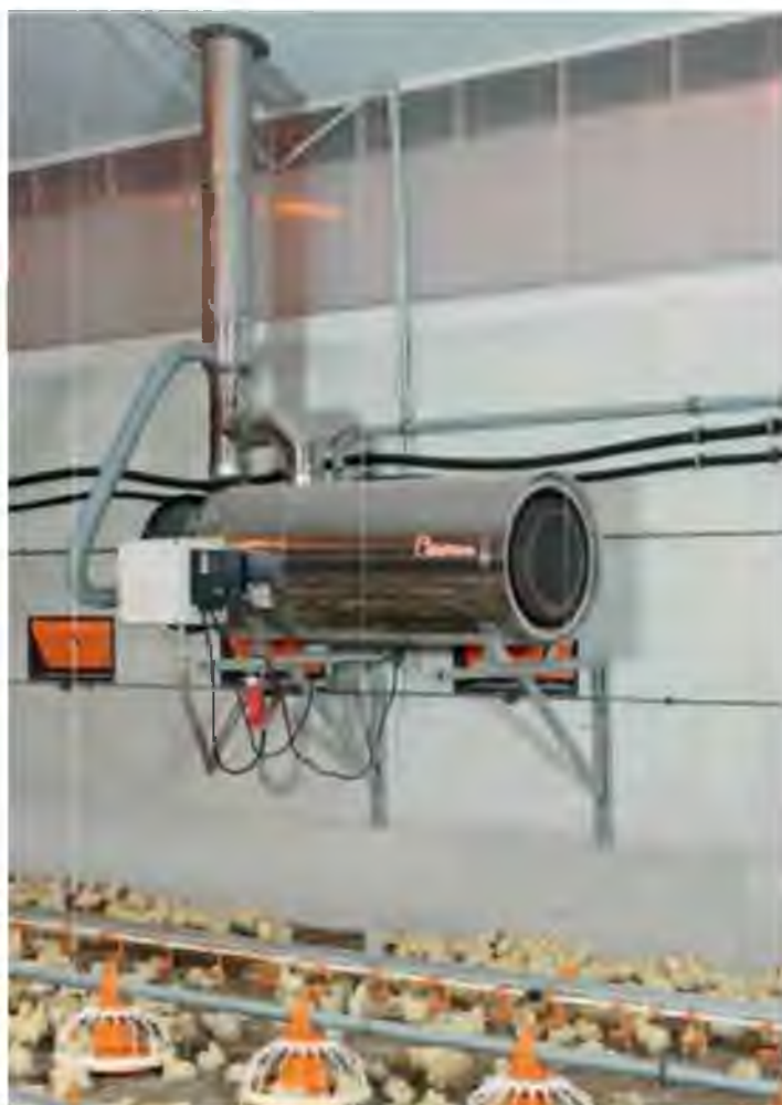
Рис. 11.19. RGA 100 – газовый обогреватель с дымовой трубой
