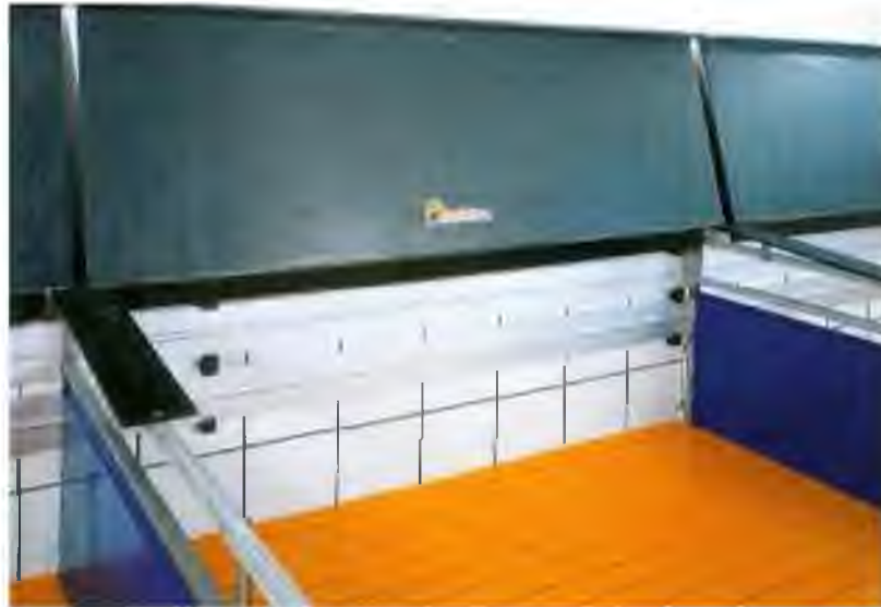
Рис. 6.23. Твин-трубы, смонтированные в зоне нахождения поросят-отъемышей
