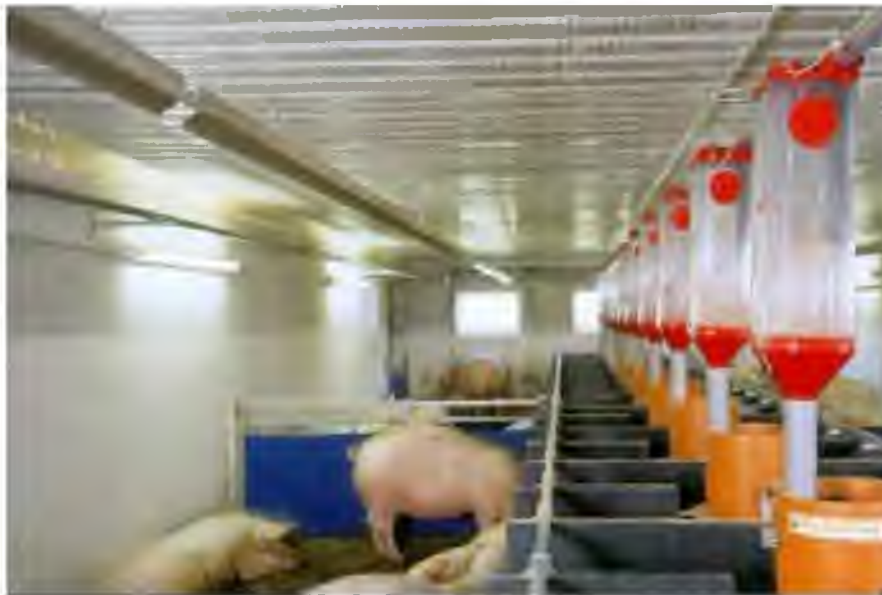
Рис. 6.19. Дельта-труба, смонтированная под приточным целевым потолком DiffAir
