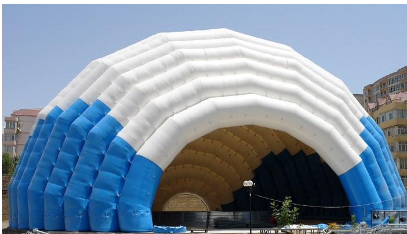
Рисунок 1 – Пневматическая конструкция
