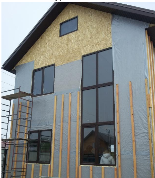
Рисунок 1 – Каркасный дом строящийся в г. Краснодаре под руководством преподавательского состава кафедры АГиПЗиС.
