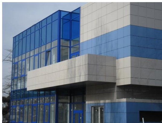
Рисунок 2 – Вентилируемая фасадная система зданий.
