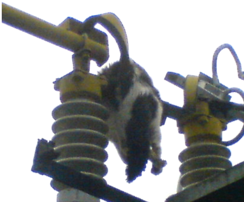
Рисунок 1.13 – Погибшее животное на высоковольтном отделителе
