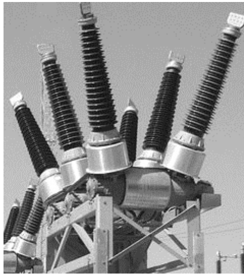
Рисунок 3.10 – Баковый элегазовый выключатель типа ЗАР1ДТ-145/ЕК
