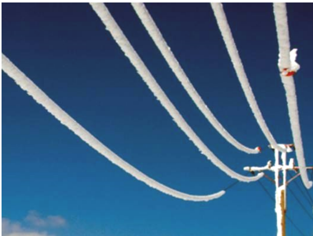
Рисунок 1.8 – Гололед и снежные образования на проводах ВЛ
