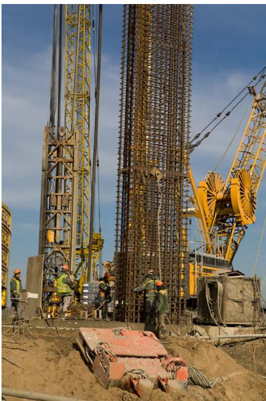
Рисунок 2.24 – Изготовление баррет
