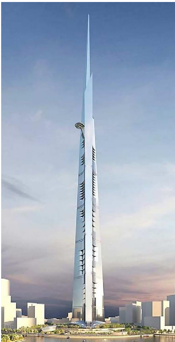
Рисунок 2.58 – Возводимое здание «Кингдом Тауэр» высотой 1007 метров в г. Джидда, Саудовская Аравия
