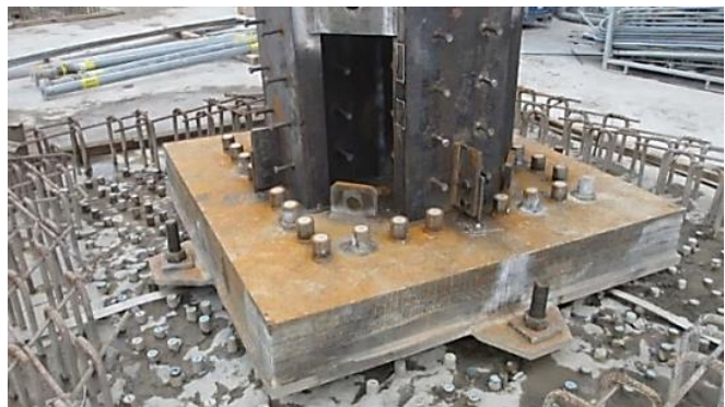
Рисунок 2.53 – Узел опирания сталебетонной колонны на коробчатый фундамент
