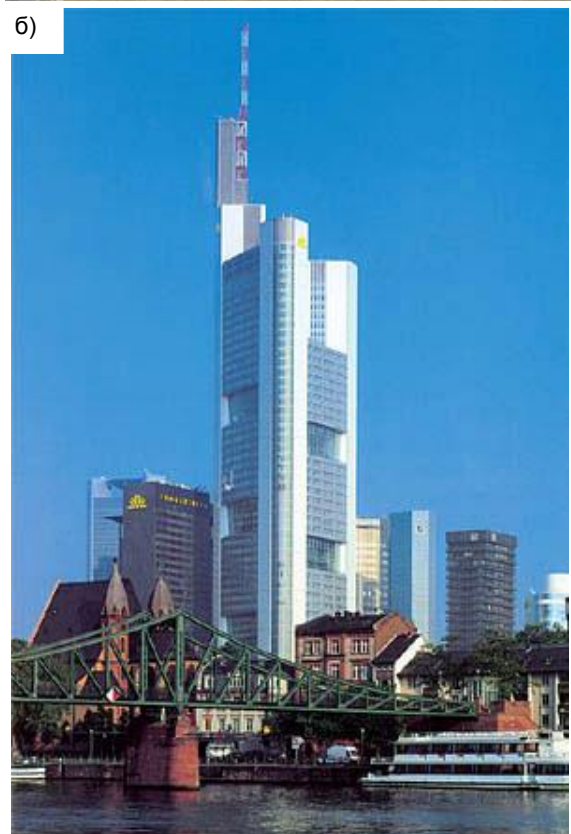
Рисунок 2.48. Высотные здания на различных типах фундаментов: а – высотное здание «Эдельвейс», Москва б – Коммерцбанк, Франкфурт-на-Майне
