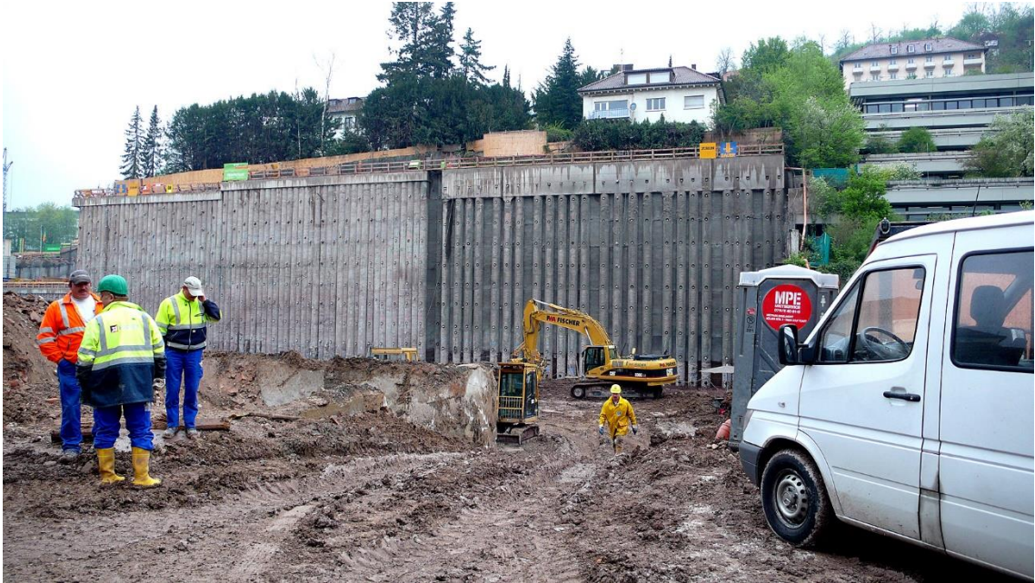
Рисунок 6.3 – Госпиталь Св.Ольги (Штутгарт, Германия) Многоярусное анкерное крепление ограждения котлована, удерживающее склон
