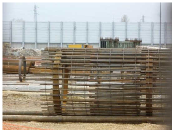
Рисунок 2.25 – Арматурный каркас сваи диаметром 2000 мм
