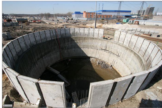
Рисунок 2.44 – Общий вид фундамента в виде опускного колодца
