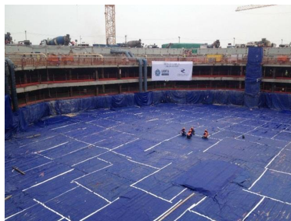
Рисунок 2.57 – Армирование фундаментной плиты здания «Лахта Центр»
