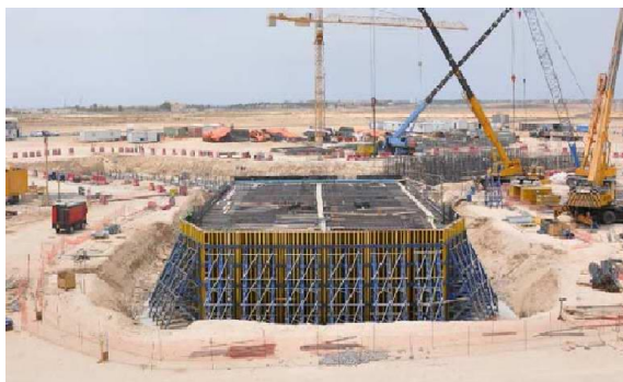
Рисунок 2.63 – Этап армирования фундаментной плиты «Кингдом Тауэр»
