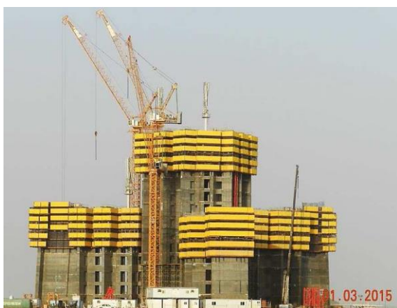
Рисунок 2.64 – Этап возведения основных несущих конструкций «Кингдом Тауэр»
