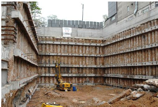
Рисунок 2.33 – Ограждение глубокого котлована из Jet-свай
