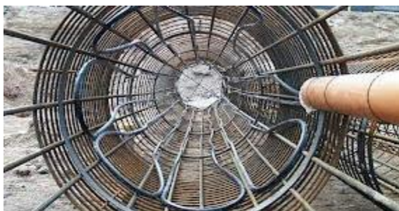
Рисунок 2.28 – Арматурный каркас и геотермальный контур в свае
