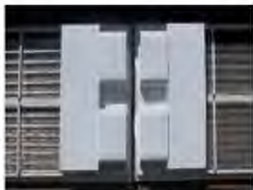
Рисунок 8.5 – Естественная вентиляция с надувными шторами
