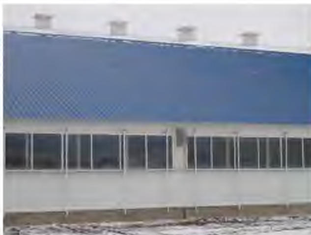
Рисунок 8.11 – Коровник, оборудованный вытяжными шахтами
