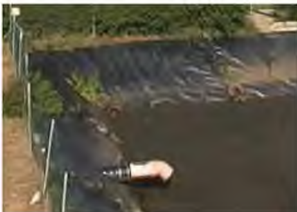
Рисунок 6.17 – Трубопровод для загрузки лагуны
