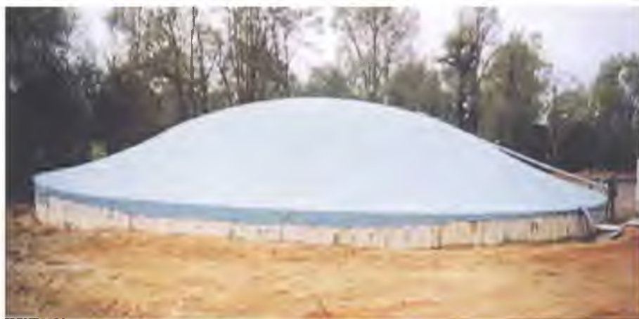
Рисунок 6.22 – Резервуар с ограничением выделения аммиака в атмосферу
