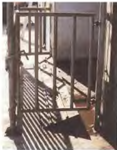
Рисунок 2.15 – Поперечный канал для схода жижи
