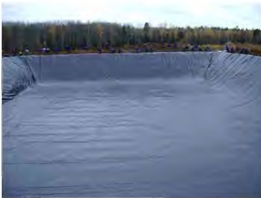
Рисунок 6.16 – Изоляция лагуны геомембраной из ПЭВД
