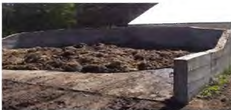
Рисунок 6.20 – Хранилище навоза с гидравлической загрузкой снизу
