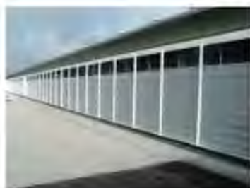
Рисунок 8.5 – Естественная вентиляция с надувными шторами
