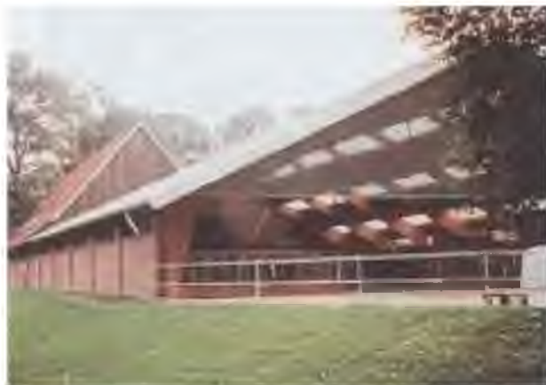
Рисунок 2.20 – Простота конструкции с открытым залом
