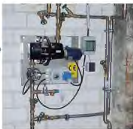
Рисунок 4.8 – Прибор для подогрева и циркуляции воды в системах поения
