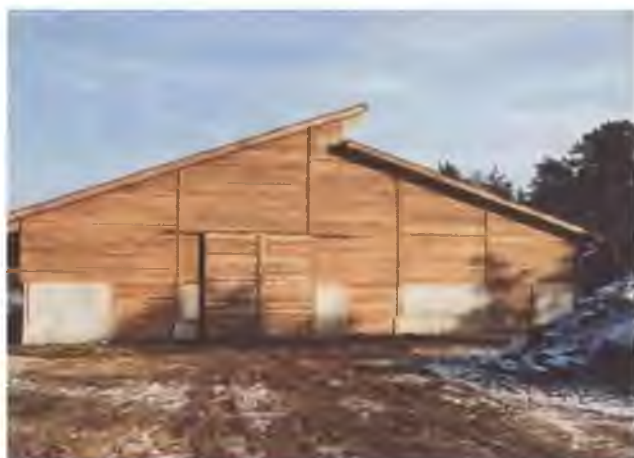
Рисунок 2.44 – Коровник с надстроенной деревянной конструкцией высотой 4,25 м
