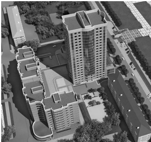
Многоэтажное административно-жилое здание в г. Новороссийск
