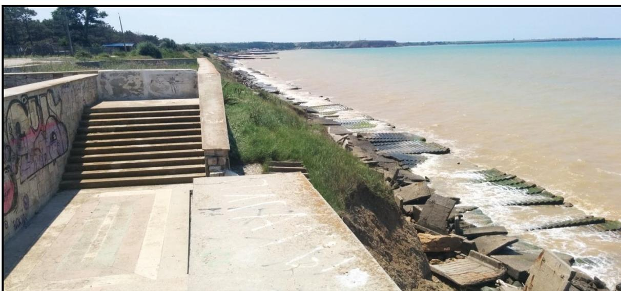
Рисунок 2 - 2016 год: аварийное состояние откосных сооружений в районе п. Песчаное, Республика Крым
