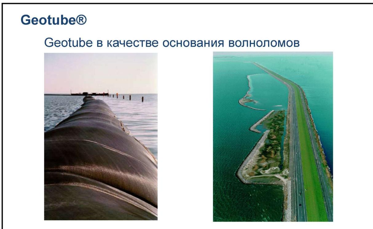
Рисунок 2 – Берегоукрепления с использованием геотекстиля
