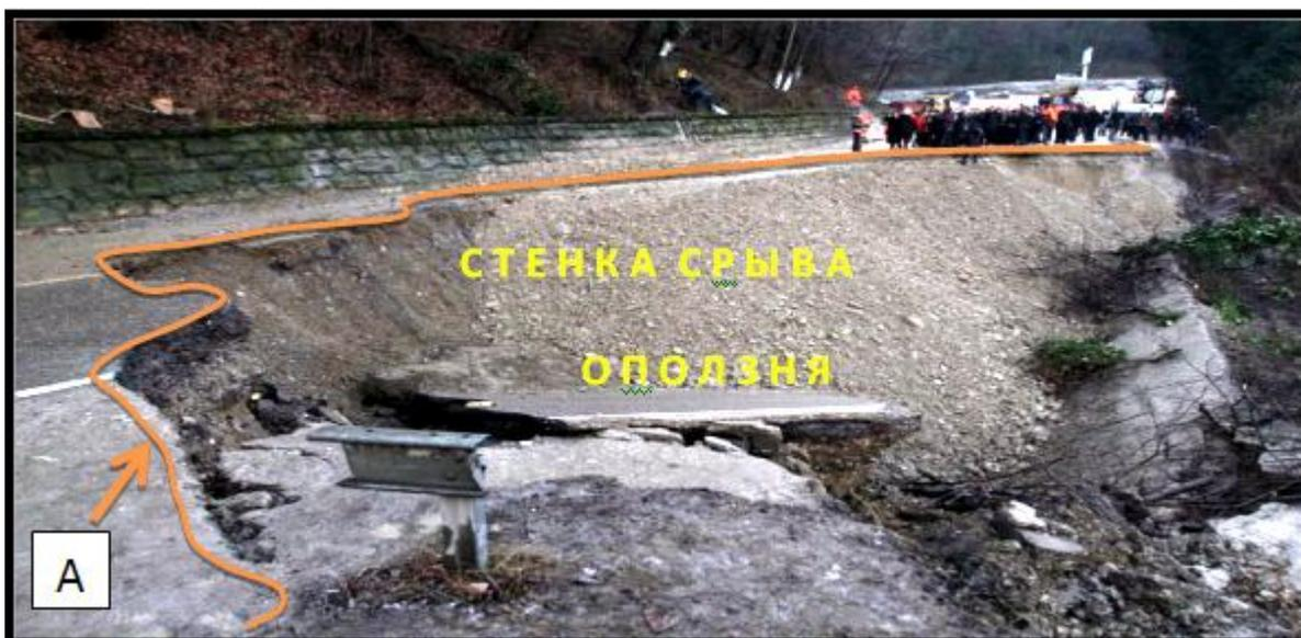
Рисунок 3 - Оползень на трассе Джубга – Сочи (под г. Туапсе, Агойский перевал), февраль 2011г. А - линия отрыва оползня. Полка автодороги практически разрушена полностью
