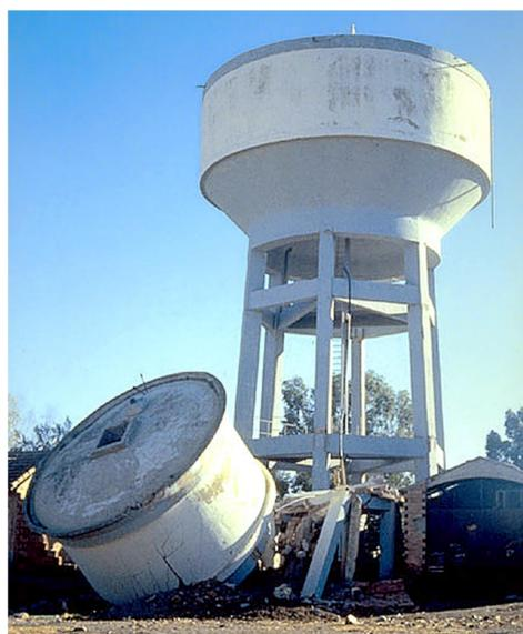
Рисунок 7.38 – Разрушение водонапорной башни (целая башня была пустой в момент землетрясения)
