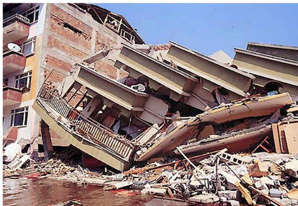
Рисунок 7.60 – Пример разрушение здания с каменным заполнением каркаса (Турция)
