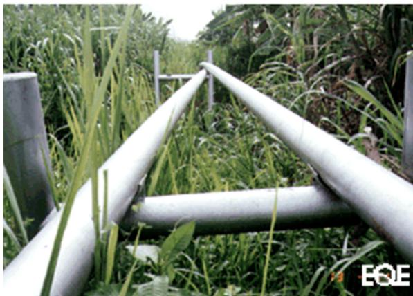
Рисунок 7.41 – Смещение незаанкеренных трубопроводов
