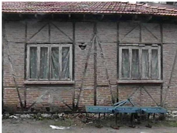
Рисунок 7.71 – Сейсмостойкое здание из местных материалов
