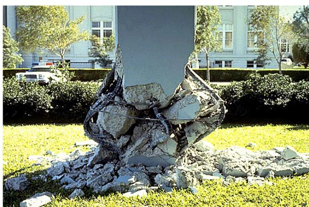
Рисунок 7.63 – Разрушение колонн нижнего этажа вертикальной составляющей сейсмической нагрузки
