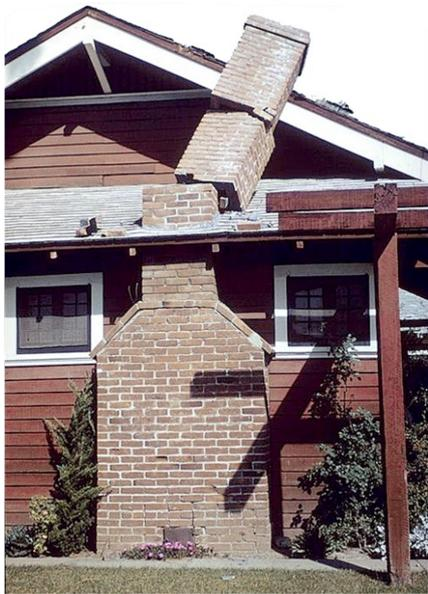
Рисунок 7.45 – Обрушение тяжелой дымовой трубы
