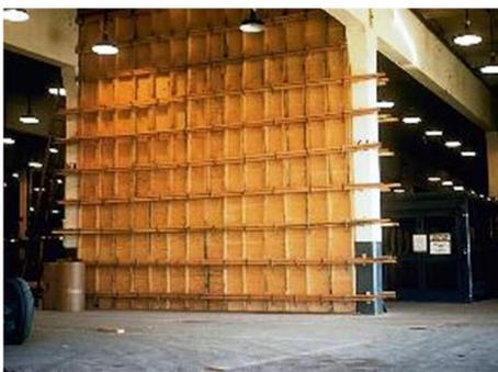
Рисунок 7.82 – Устройство диафрагмы жесткости в цехе
