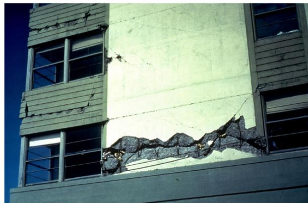
Рисунок 7.57 – Типичные повреждение диафрагмы при землетрясении
