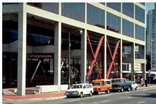
Рисунок 7.81 – Усиление здания диагональными связями
