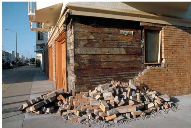
Рисунок 7.32 – Совмещение в одной конструкции материалов с существенно разными свойствами: кирпич и дерево
