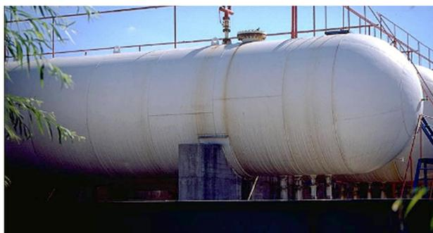
*Рисунок 7.73 – Повреждение опоры горизонтальной емкости с высоким центром тяжести*
