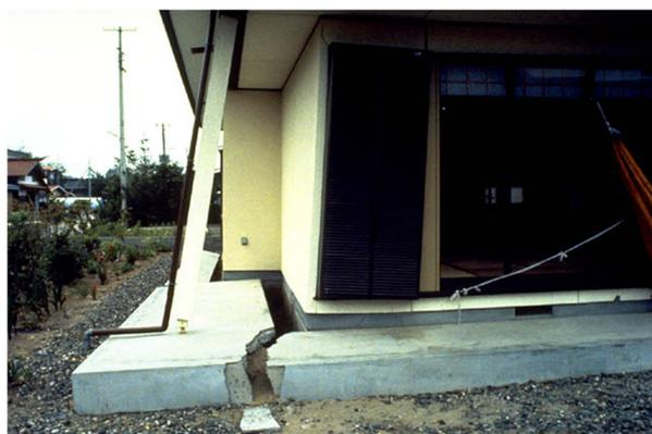
Рисунок 7.20 – Отсутствие арматуры в железобетонной конструкции
