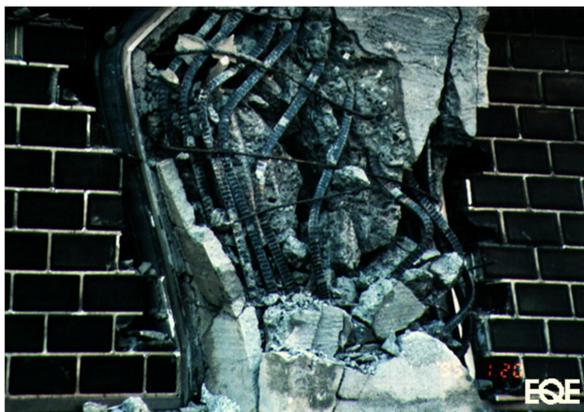
Рисунок 7.62 – Недостаток поперечного армирования в разрушенной колонне
