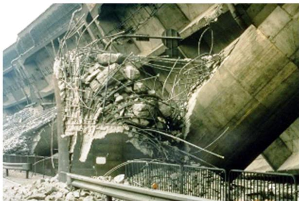
*Рисунок 7.72 – Повреждение опоры эстакады вертикальной нагрузкой*
