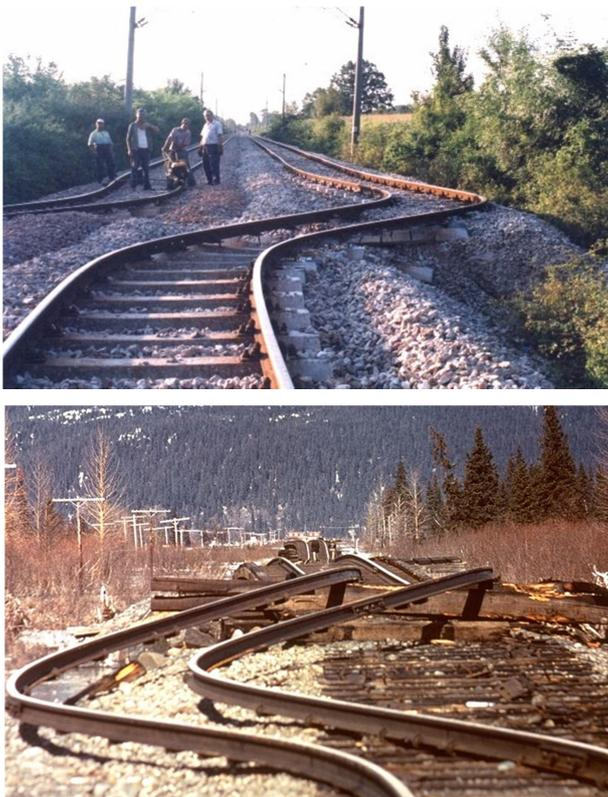
Рисунок 1.4 – Деформация железнодорожных рельсов L-волнами во время землетрясений в Турции и на Аляске
