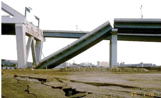
Рисунок 1.8 – Повреждение пролета моста из-за разжижения грунта
