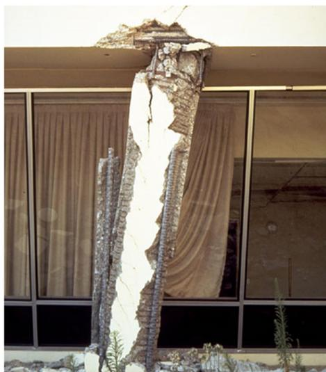
Рисунок 7.16 – Брак строительства: продольная арматура оборвана; продольная и поперечная арматуры не связаны между собой; продольная арматура имеет изгибную жесткость больше, чем защитный слой бетона
