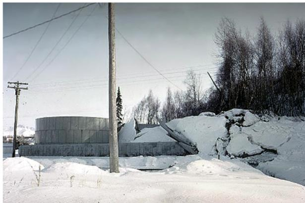
Рисунок 7.78 – Пожар и разрушение резервуаров оползнем вследствие землетрясения
