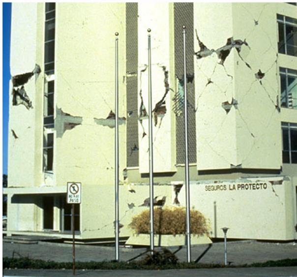
Рисунок 4.3 – Разрушение угловых и разнопрочных простенков
