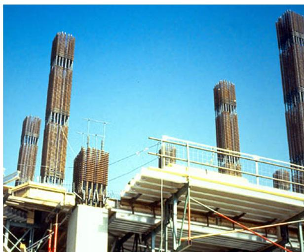
Рисунок 7.19 – Пример армирования колонн для восприятия сейсмических нагрузок
