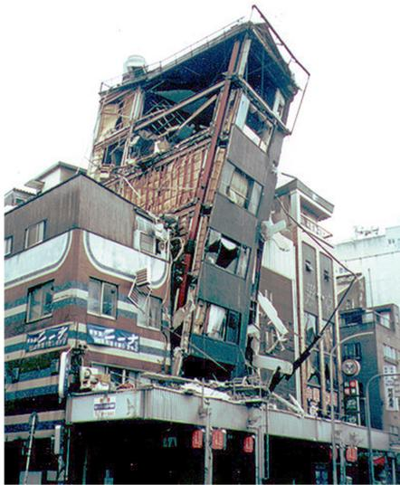
Рисунок 7.66 – Деформации безсвязевого каркаса
