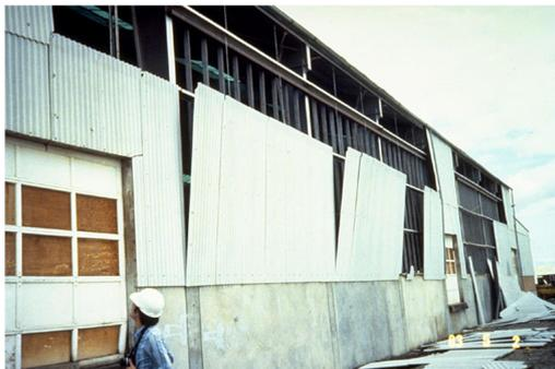
Рисунок 7.68 – Повреждение ограждающих панелей, жестко закрепленных на металлическом каркасе
