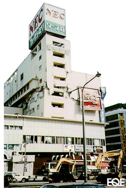
Рисунок 7.12 – Повреждение здания с большими перепадами по высоте
