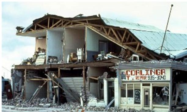
Рисунок 7.70 – Повреждение здания из местных материалов
