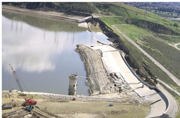
Рисунок 1.10 – Разрушение дамбы из-за разжижения водонасыщенного грунта
