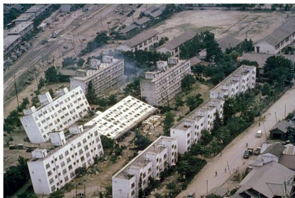
Рисунок 1.11 – Опрокидывание зданий из-за разжижения грунта
