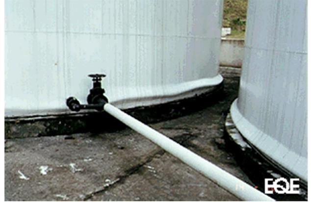
*Рисунок 7.76 – Повреждение резервуара по типу «слоновой ступни»*
