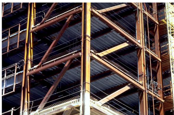
Рисунок 7.64 – Пример сейсмостойкого здания со стальным каркасом
