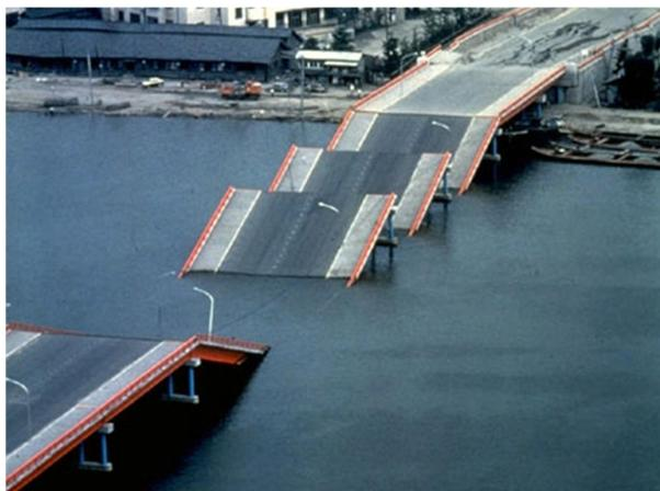
Рисунок 1.13 – Обрушение пролетов моста
