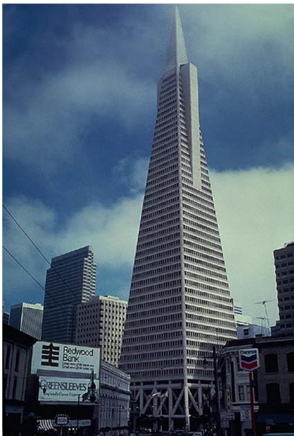
Рисунок 7.1 – Пример сейсмостойкого здания (Сан-Франциско, США) с большепролетными помещениями на нижнем этаже
