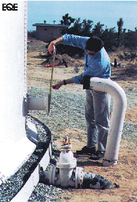
*Рисунок 7.75 – Отрыв анкерного крепления и разрыв жесткого соединения резервуара с трубопроводом*
