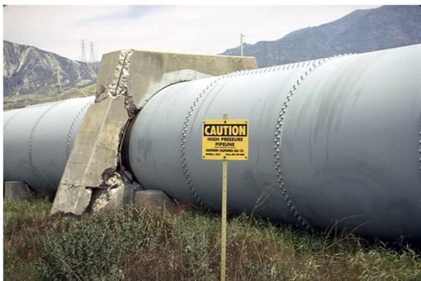
Рисунок 7.40 – Транс-Аляскинский водопровод. Жесткое крепление трубы большого диаметра
