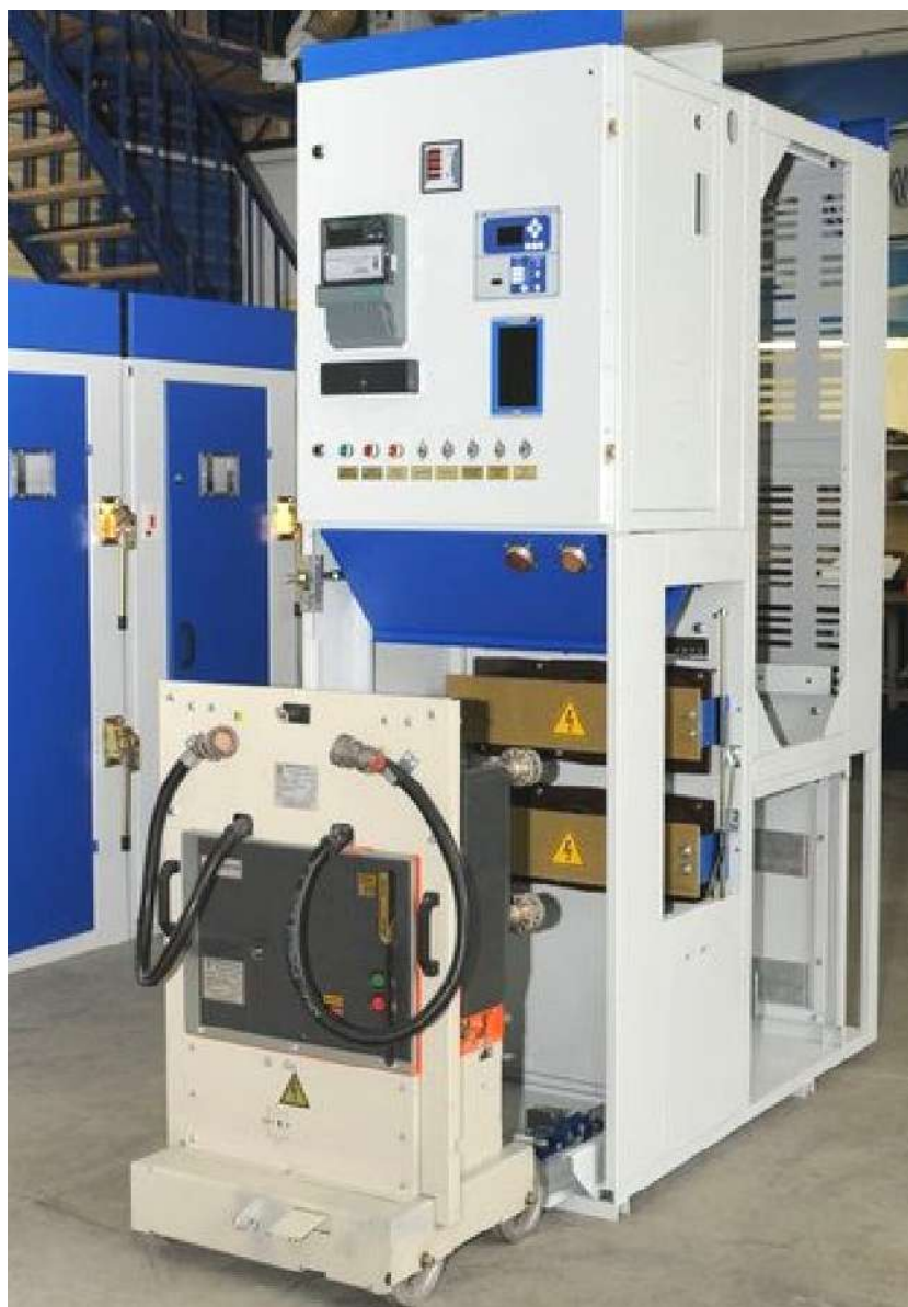
Рисунок 5.5 – Комплектное распределительное устройство серии К-63
