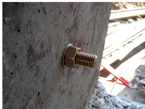
Схема заложения стеновых марок
