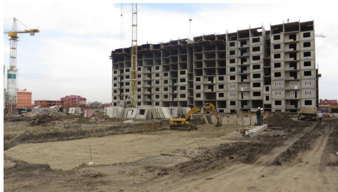
Рис. 7. Этап выполнения промежуточной подушки для многоэтажного жилого здания
