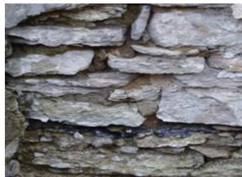
Рис. 1.2. Фотографии внешней стороны кладки бутовых фундаментов со следами физического износа и снижением прочностных свойств.
