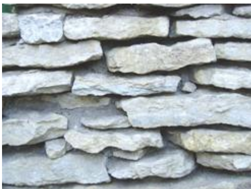
Рис. 1.2. Фотографии внешней стороны кладки бутовых фундаментов со следами физического износа и снижением прочностных свойств.
