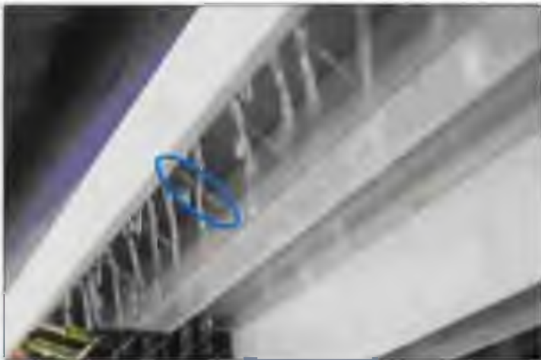
Рис. 11.29. Верхний профиль с перфорированной трубой и дефлектором
