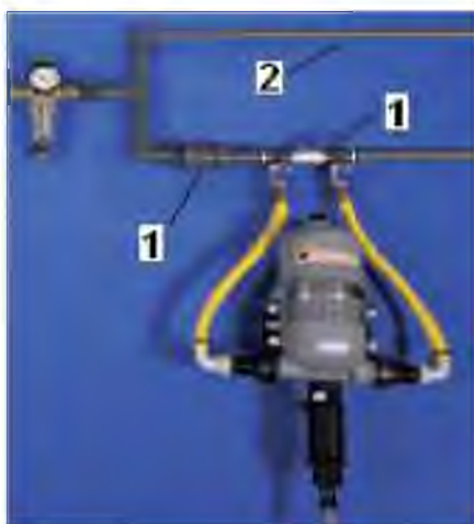
Рис. 4.6. Применение медикатора в кольцевом водопроводе:
