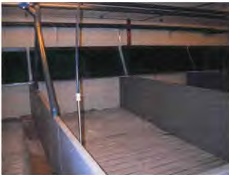
Рис. 1.8. Групповой станок для откорма свиней компании Asofipinki (Дания)
