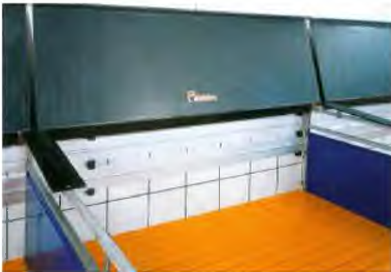
Рис. 6.23. Твин-трубы, смонтированные в зоне нахождения поросят-отъемышей
