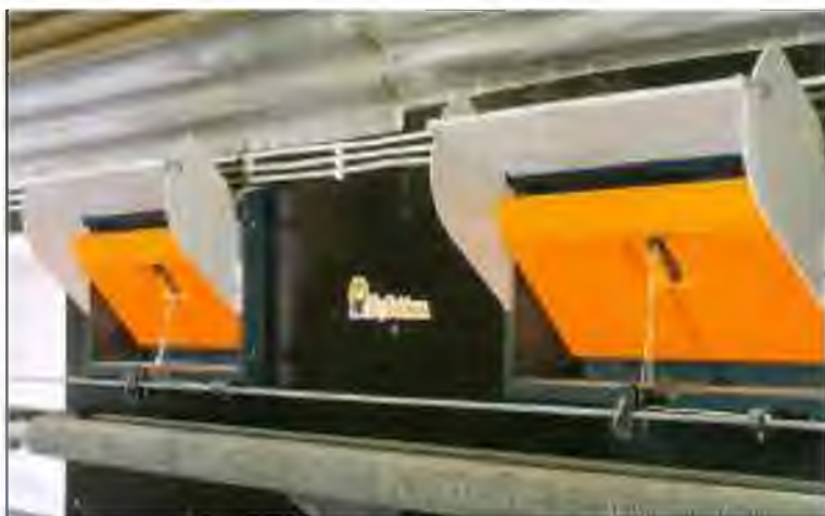
Рис. 6.22. Ребристые трубы в комбинации с приточными клапанами CL 1200
