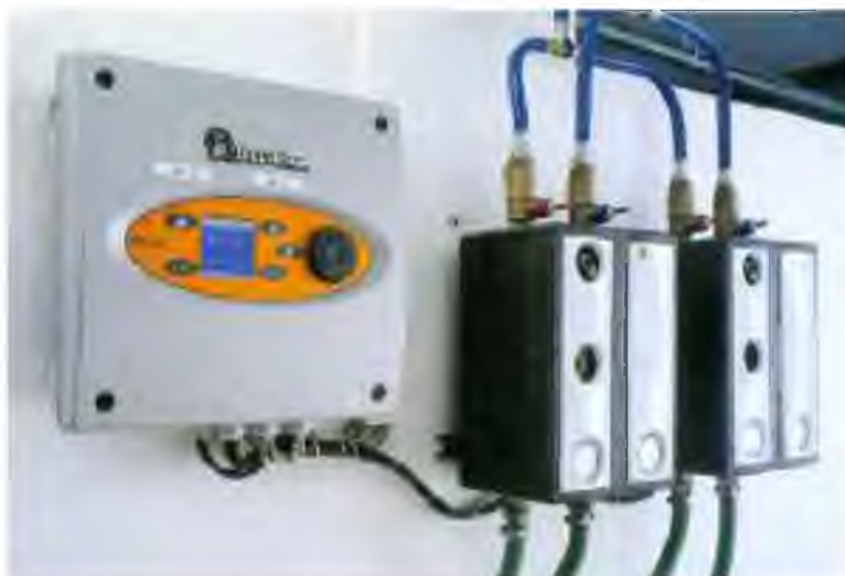
Рис. 6.25. Компьютер MC 235 для управления микроклиматом в помещении и трехходовым регулировочном кране для водяного отопления
