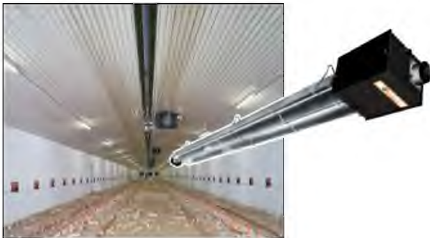
Рис. 11.22. Инфракрасный излучатель ВДНБ в помещении для откорма бройлеров
