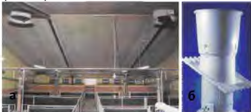
Рис. 6.3. Внутренний вид свиарника-маточника (а), оборудованного перфорированным потолочным перекрытием и вытяжными шахтами DA-600 (б)
