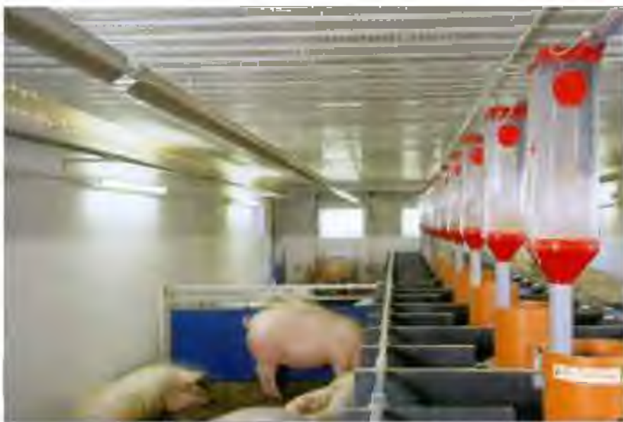
Рис. 6.19. Дельта-труба, смонтированная под приточным целевым потолком DiffAir
