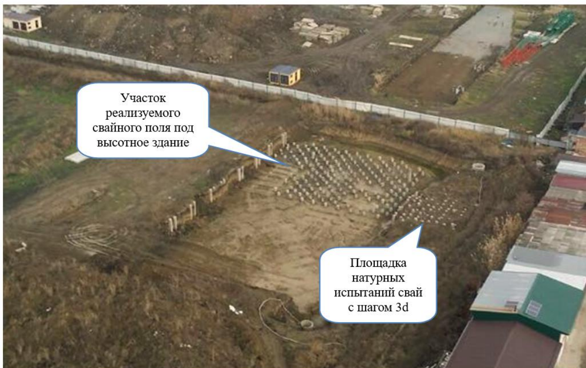
Рис. 11 – Этап массовой забивки свай. Справа показана ранее выполненная тестовая площадка
