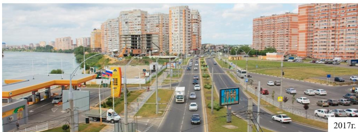
Рис. 1 – Застройка ул. Кубанская Набережная г. Краснодара за последние 15 лет
