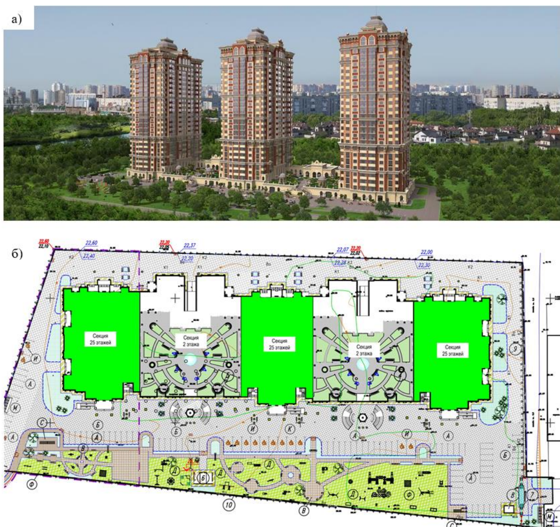
Рис. 3 – Общий вид жилого комплекса «Дом Романовых» г. Краснодар (а); Генеральный план участка (б)
