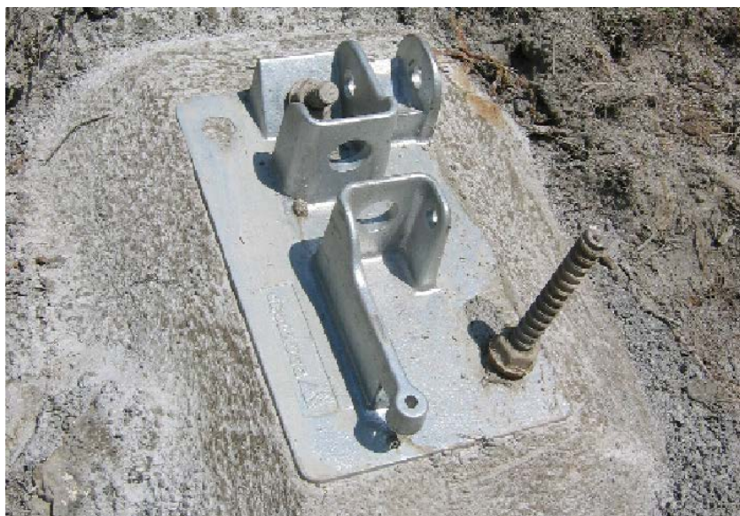
Рисунок 4.7 – Опорная пластина после стыковки с грунтовым анкером
