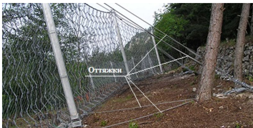
Рисунок 4.10 – Натяжные канаты в верхней и нижней части барьера
