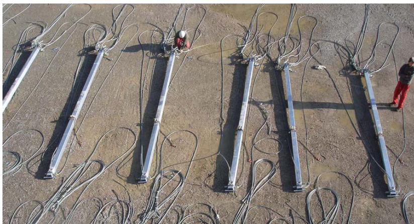
Рисунок 4.4 – Подготовка опор гибкого противокамнепадного барьера к монтажу
