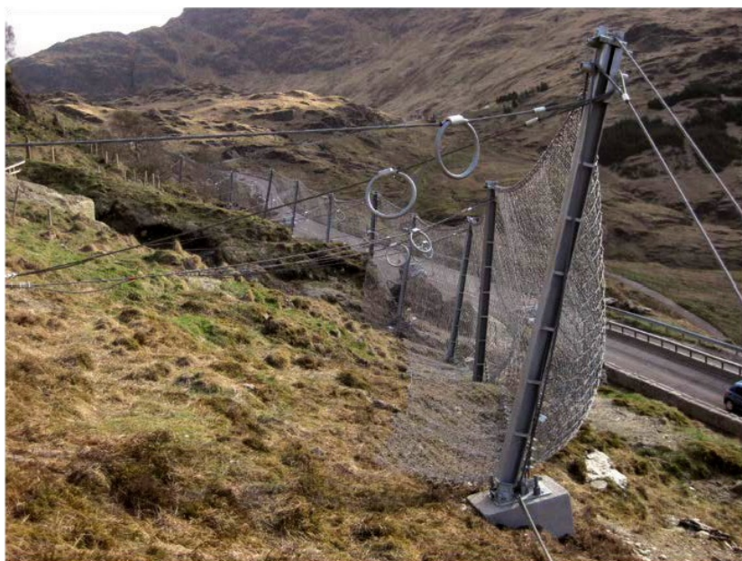
Рисунок 1.5 – Гибкий противокаменная падный барьер: а – схема сооружения (сечение 1-1); б – общий вид
