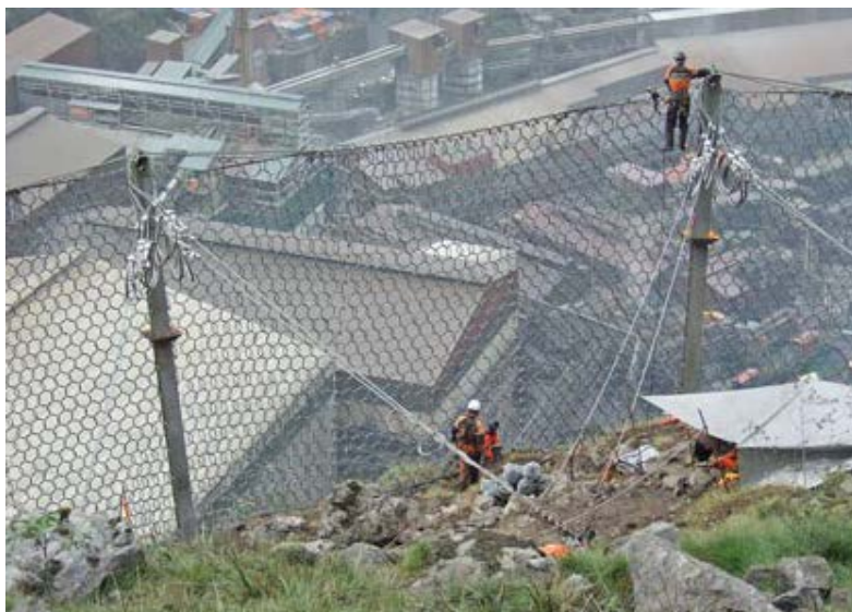
Рисунок 1.12 – Гибкие противокаменные барьеры
