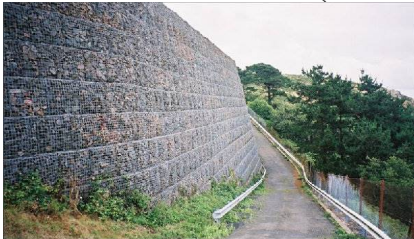
Рисунок 1.3 – Защитное сооружение из габионов: а – схема сооружения; б – общий вид
