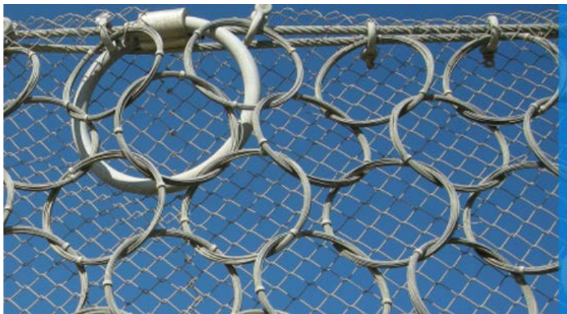
Рисунок 4.15 – Амортизирующий элемент на натяжном канате
