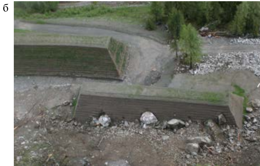
Рисунок 1.5 – Защитная дамба: а – схема сооружения; б – общий вид
