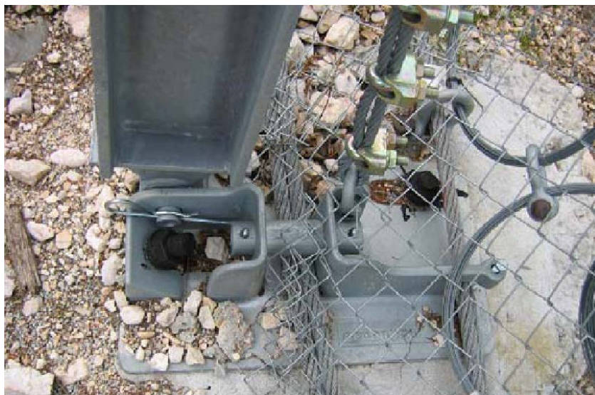
Рисунок 4.8 – Опорная пластина, совмещенная с опорой
