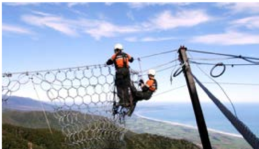
Рисунок 4.12 – Монтаж секции сетки на несущий канат
