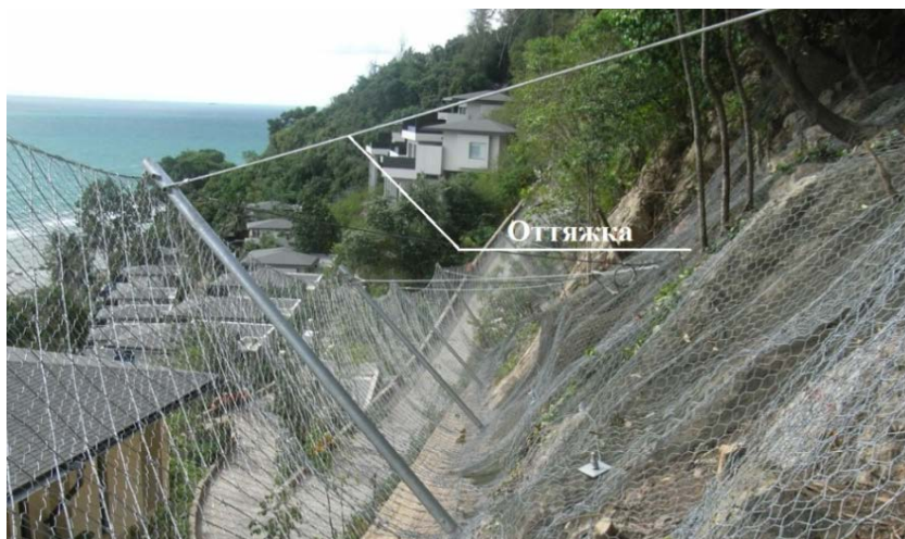
Рисунок 4.9 – Натяжной канат (оттяжка) гибкого противокамнепадного барьера компании Massaferrì
