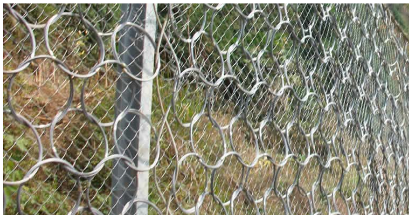
Рисунок 4.14 – Высокопрочная стальная сеть ROCCO® компании Geobrugg в сочетании с мелкозернистой сетью, позволяющей сдерживать обломки породы мелкого диаметра
