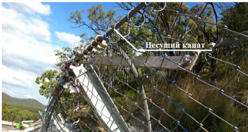
Рисунок 4.11 – Несущий канат в верхней части гибкого барьера
