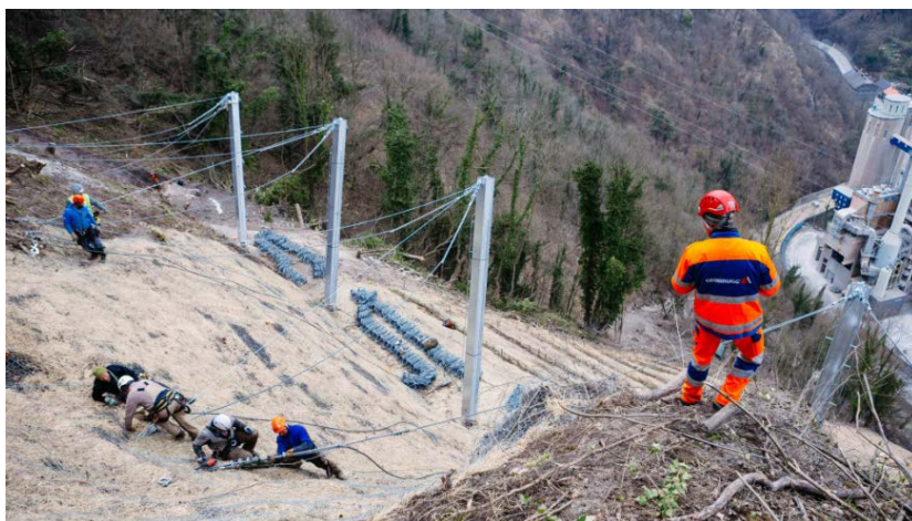
Рисунок 4.5 – Монтаж опор гибкого противокамнепадного барьера
