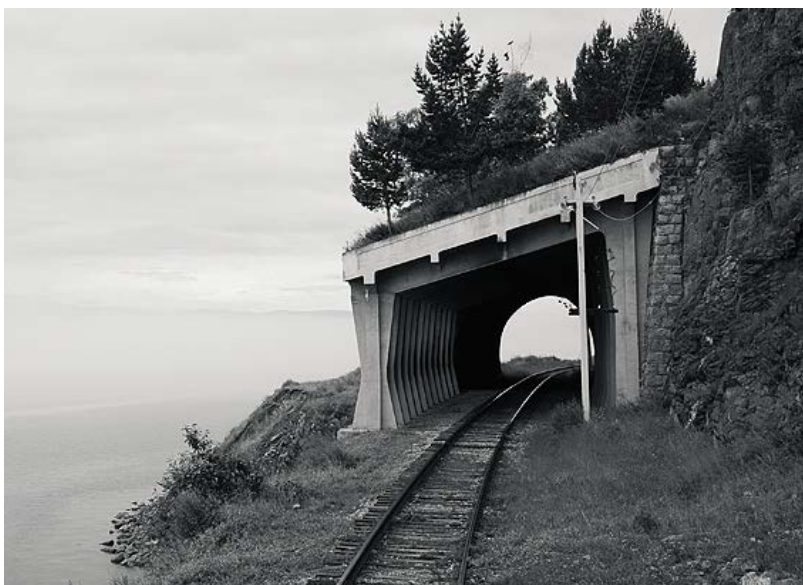
Рис. 1.11. Противообвальная железобетонные галереи: а – противообвальная галерея, США; б – галерея на Кругобайкальской железной дороге, Россия
