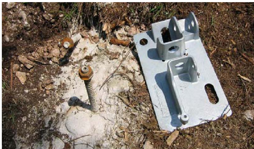
Рисунок 4.6 – Опорная пластина до стыковки с грунтовым анкером
