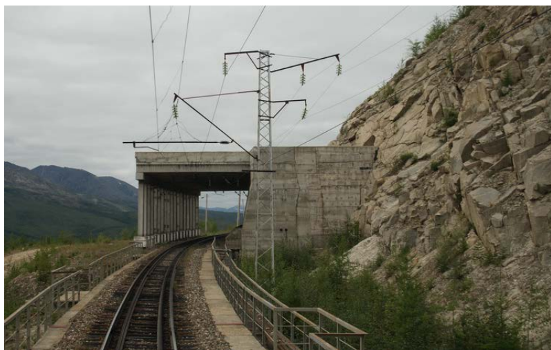
Рисунок 2.6 – Железобетонные галереи на Байкало-амурской магистрали, Россия
