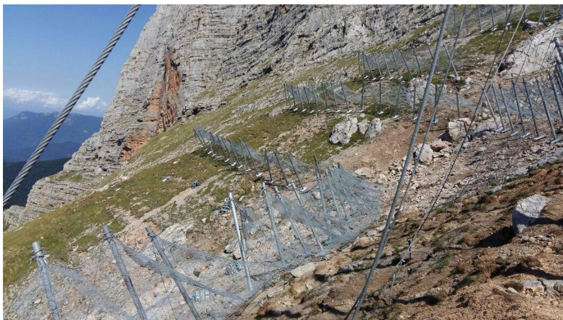
Рисунок 6 – Линии смонтированных снегоудерживающих барьеров. Август 2017 г. Fig. 6 – Lines of mounted snow-retaining barriers. August 2017
