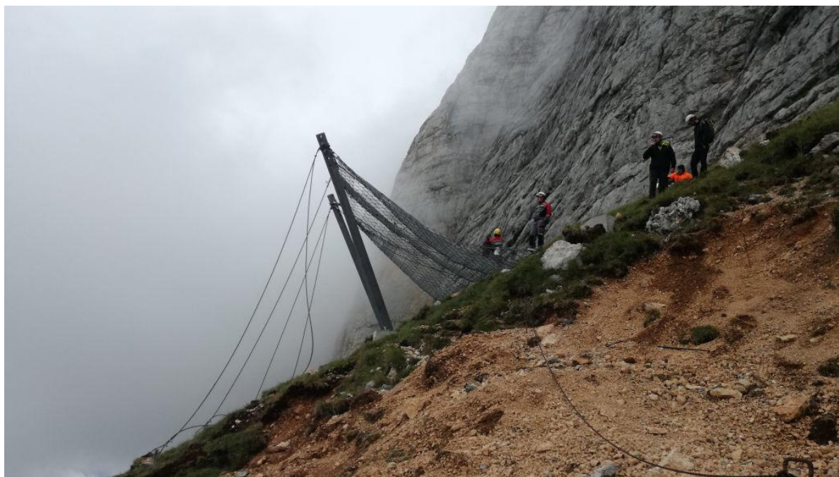
Рисунок 6 – Монтаж снегоудерживающего барьера. Август 2017 г. Figure 6 – Installation of the snow-retaining barrier. August 2017
