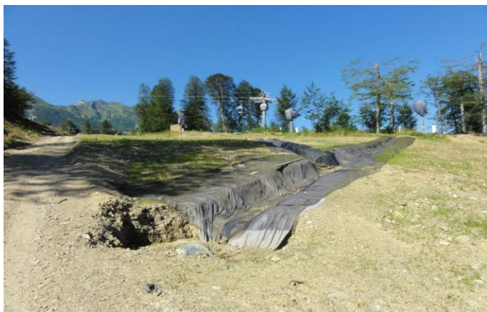
Рисунок 47 – Использование синтетических пленок для замедления водно-эрозионных процессов на лыжных трассах (Роза Хутор)
