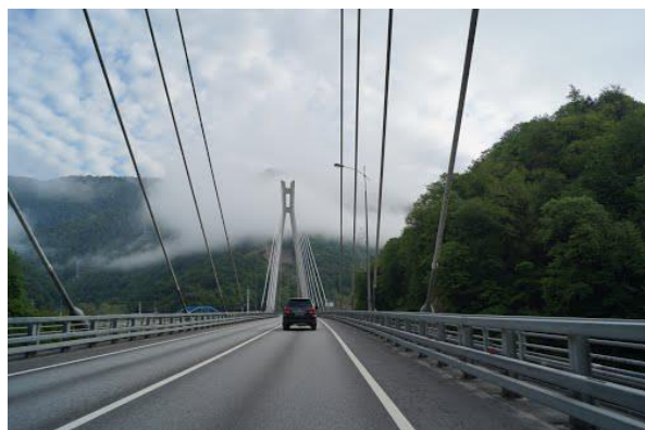
Рисунок 33 – Дорога «Адлер – Красная Поляна» после строительства
