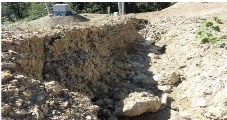
Рисунок 46 – Проявление сильной водной эрозии (размыв) по линии лыжных трасс
