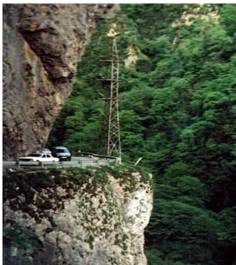
Рисунок 32 – Дорога «Адлер – Красная Поляна» до реконструкции
