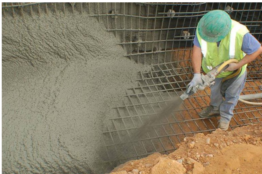
Рисунок 1 – Торкретирование откоса дамбы – эффект гидротехнических плит
